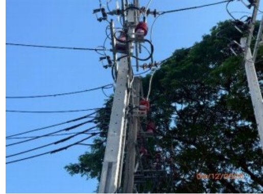
รูปที่ 30 ชุดอุปกรณ์ป้องกันการระเบิดของหม้อแปลง
