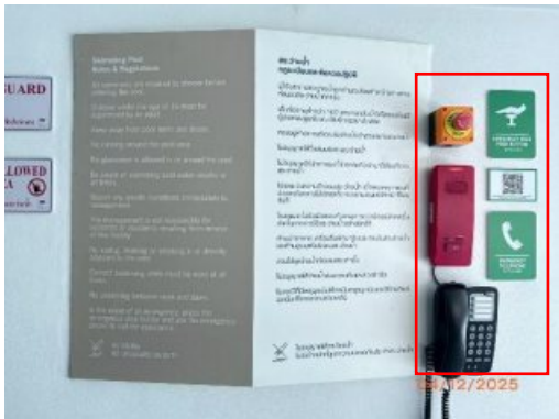
รูปที่ 68 อุปกรณ์สื่อสารกรณีเกิดเหตุฉุกเฉิน
