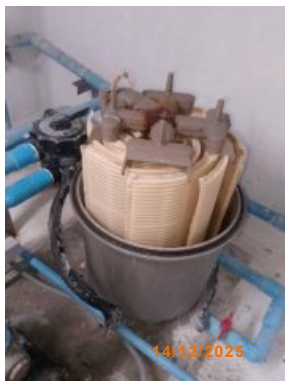
รูปที่ 72 การทำความสะอาดเครื่องกรองน้ำ
